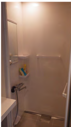
シャワー室 bathroom
